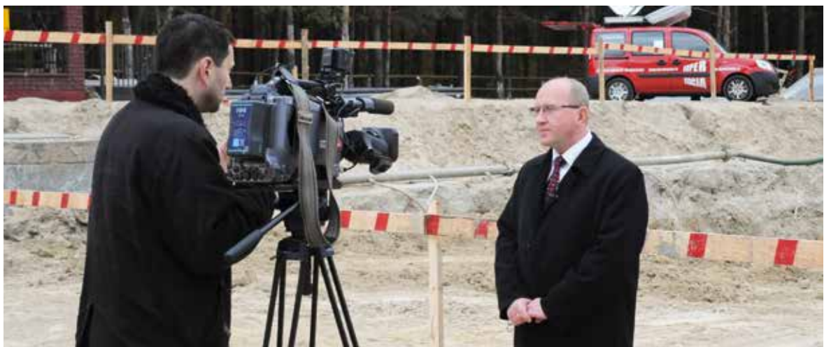
Prof. Henryk Skarżyński, na terenie budowy Światowego Centrum Słuchu, udziela wywiadu red. Sławomirowi Majcherowi z TVP 3 Warszawa (2011).
